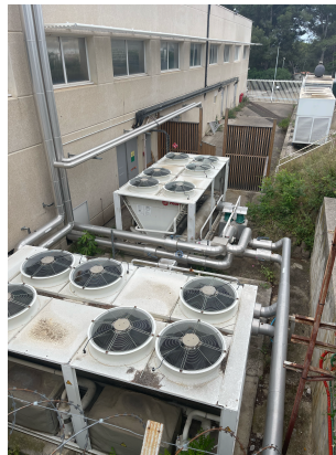
Figure 9 : Groupe froid A et B fonctionnant en alterné
